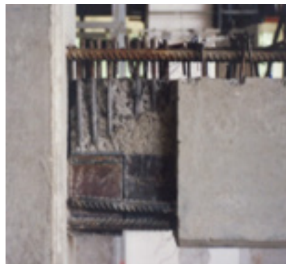
Foto 1. Conexión soldada en el lecho inferior.
