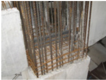
Foto 3. Conexión emulativa del concreto reforzado.
