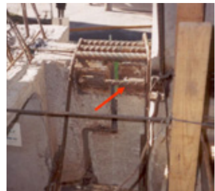
Foto 2. Conexión soldada en el lecho superior.
